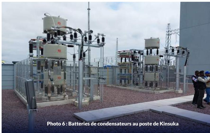
Photo 6 : Batteries de condensateurs au poste de Kinsuka
