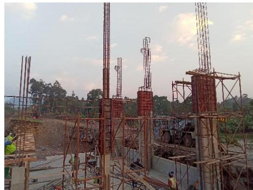
Figure 42 : Vue ferrailage et coffrage colonnes
