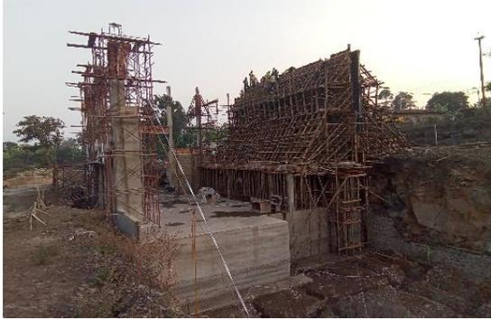
Figure 43: *Vue ferrailage voiles et colonnes*
