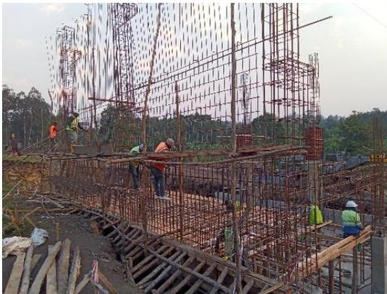
Figure 41: Vue ferrailage voiles et colonnes
