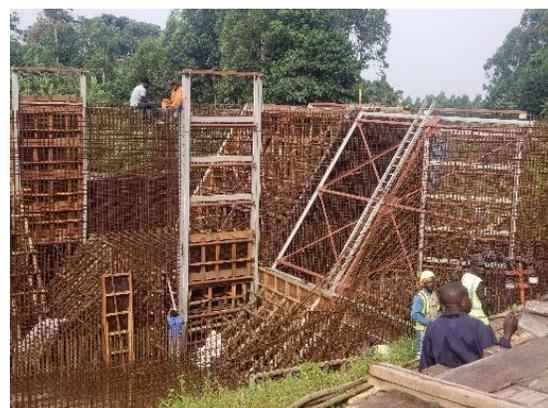
Figure 34 : Ferrailage voiles & fixation des glissières
