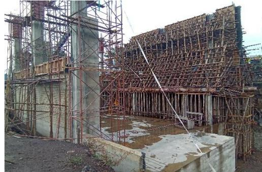
Figure 44: *Vue coffrage et bétonnage voiles*
