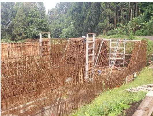
Figure 31 : Ferrailage voiles & fixation des glissières
