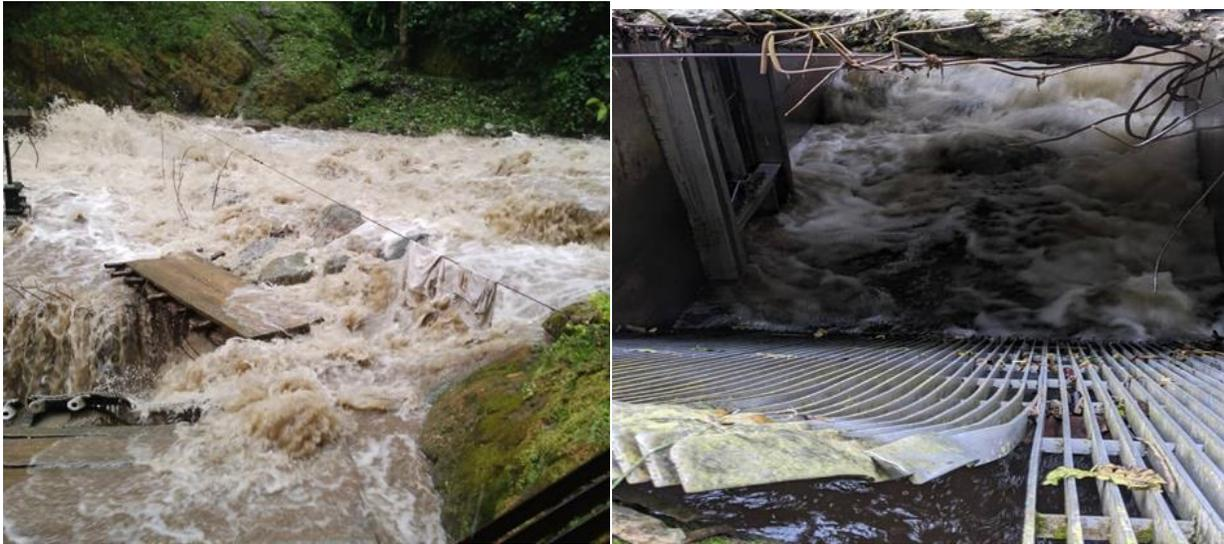
*Figure 6* : Lors de la crue, les grilles de l'OPE sont emportées, ce qui facilite le remplissage du bassin de décantation par des pierres
