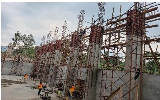
Figure 49: *Vue coffrage colonnes et aperçu voiles*
