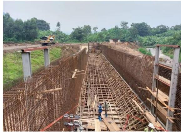
Figure 29 : Coffrage des voiles et ferrailage CMC et implantation des glissières
