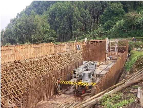
Figure 32 : Ferrailage et coffrage voiles OPE
