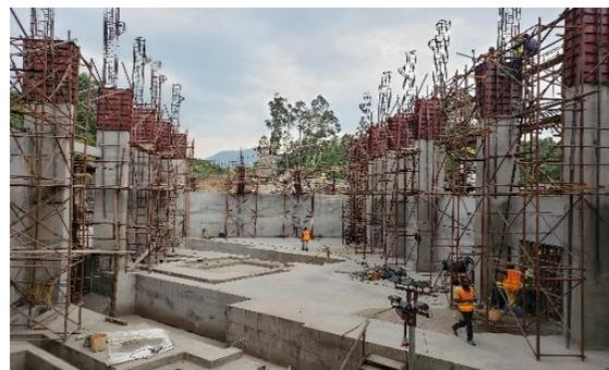
Figure 50: *Vue coffrage colonnes et aperçu voiles*
