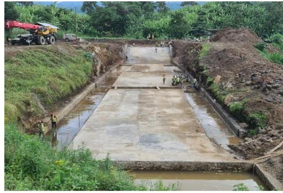
Figure 26 : *Bétonnage fondation Zone OPE*
