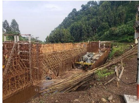
Figure 33 : Ferrailage et coffrage voiles OPE
