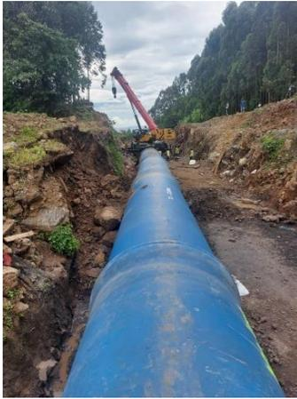
Figure 40: Pose continuité tuyau DN200 après CMC et Pose continuité tuyau DN200 après CMC
