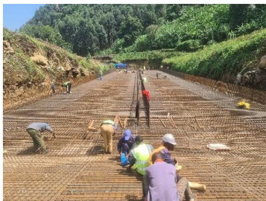
Figure 27 : *Ferrailage dalle et voiles OPE*
