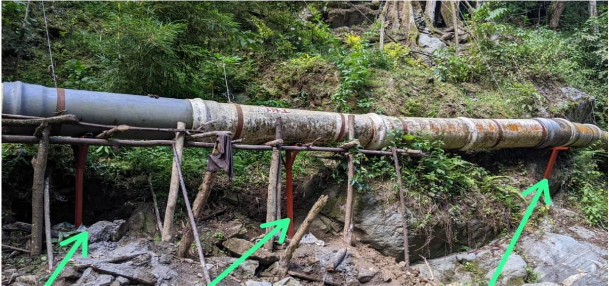
Figure 8 : Renforcement des supports des tuyaux par des échafaudages métalliques et remplacement des câbles de support.
