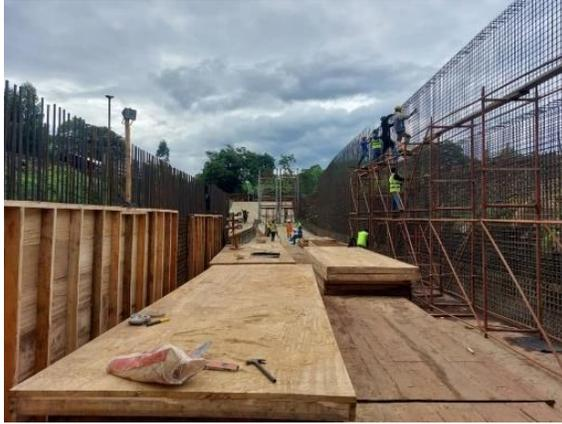
Figure 30 : Ferrailage dalle et attente des voiles de l'ouvrage
