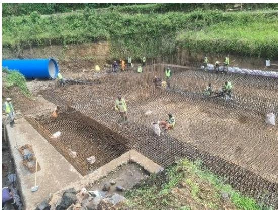
Figure 28 : *Ferrailage dalle et voiles OPE*
